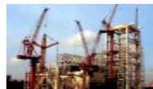
上海外高桥电厂
